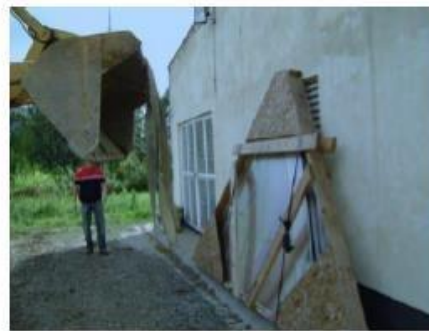
Almacenamiento correcto de los paneles del domo
