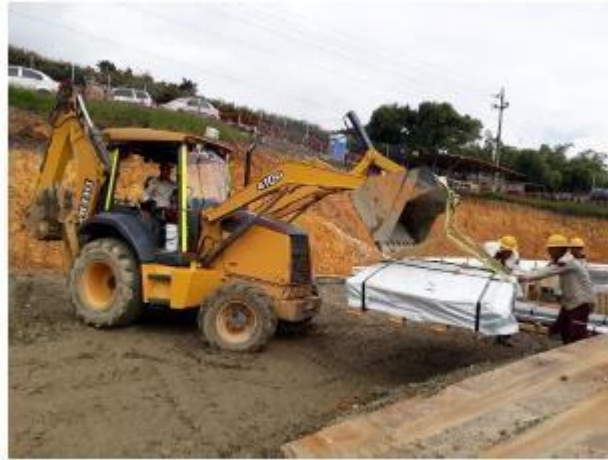
Fotografía 1. Descargue y almacenamiento de piezas del domo
