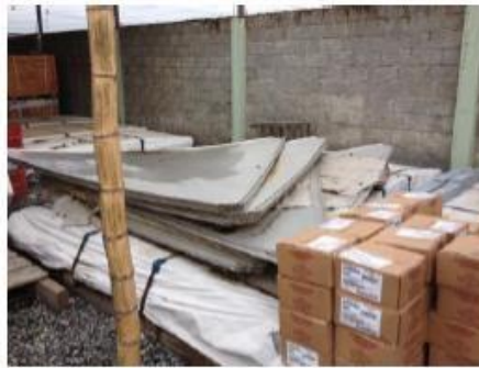
Almacenamiento incorrecto de los paneles del domo
