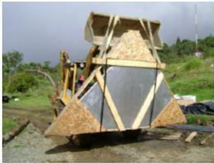
Almacenamiento correcto de los paneles del domo
