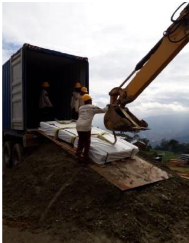
Fotografía 2. Rampa para descarga de piezas del domo
