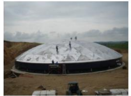
Consecuencia- Manchas en los paneles
