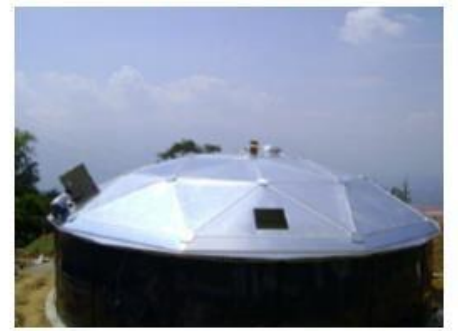
Consecuencia: Paneles sin deterioro ni manchas
